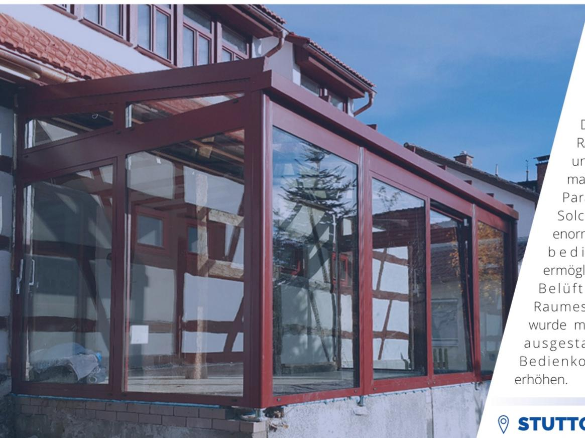
Die Profile wurden in der Farbe RAL 8017 lackiert. In den Vorder- und Seitenwänden montierte man sowohl Dreh-Kipp- als auch Parallelschiebekipp-Fenster. Solche Konstruktionen sind enorm bequem und einfach zu bedienen. Zusätzlich ermöglichen sie eine effektive Belüftung des gesamten Raumes. Die Überdachung wurde mit getönten Scheiben ausgestattet, welche den Bedienkomfort zusätzlich erhöhen.
